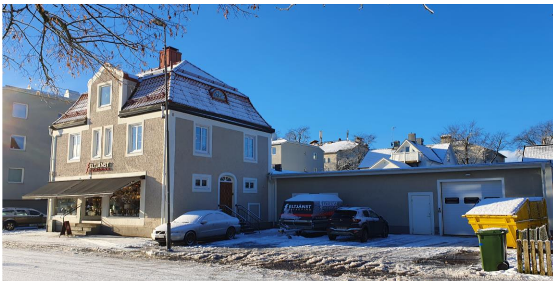
Figur 9 visar hur byggnaden på Glasmästaren 4 ser ut idag efter fasadrenovering och tillbyggnad.
